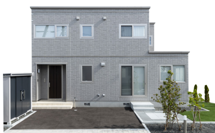
外観写真 (2023年9月撮影)
