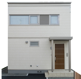
外観写真 (2023年5月撮影)
