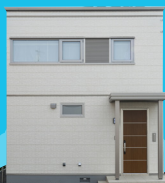
外観写真 (2023年5月撮影)
