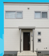
外観写真 (2022年7月撮影)
